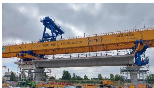
Poutre de lancement
