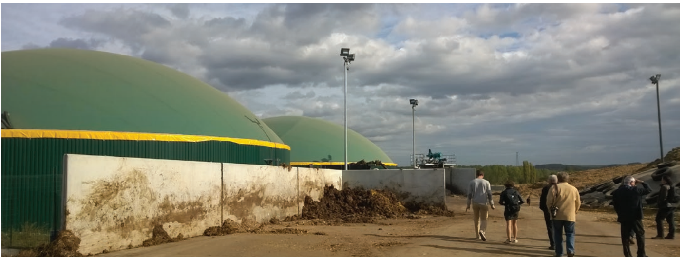
VISITE DU PROJET METHACHRIST, EXPLOITATION D'UNE UNITÉ DE MÉTHANISATION DE MATIÈRES ORGANIQUES ET DE DÉCHETS – ATELIERS TERRITORIAUX ÉNERGIE/PLANIFICATION ORGANISÉS PAR LE SYNDICAT MIXTE POUR LE SCOTERS, AVEC L'APPUI DE L'ADEUS, OCTOBRE 2017
