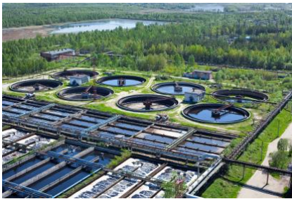
Figure 5 : Bassins de traitement (source : Rackam)
