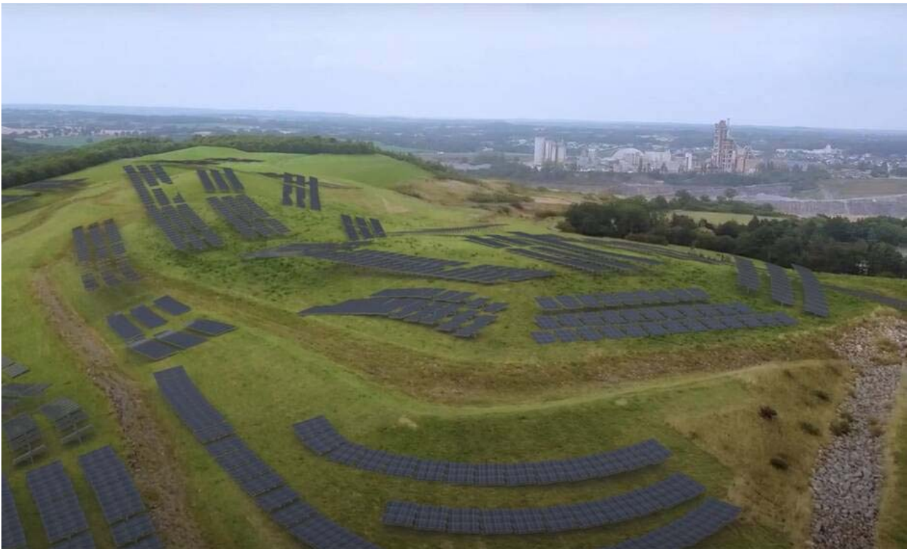
Le merlon de la cimenterie Lafarge, où est prévue la centrale solaire photovoltaïque, donne du côté de Bréal-sous-Vitré. | CAPTURE D'ÉCRAN YOUTUBE / PROJET DE CENTRALE SOLAIRE À SAINT-PIERRE-LA-COUR
