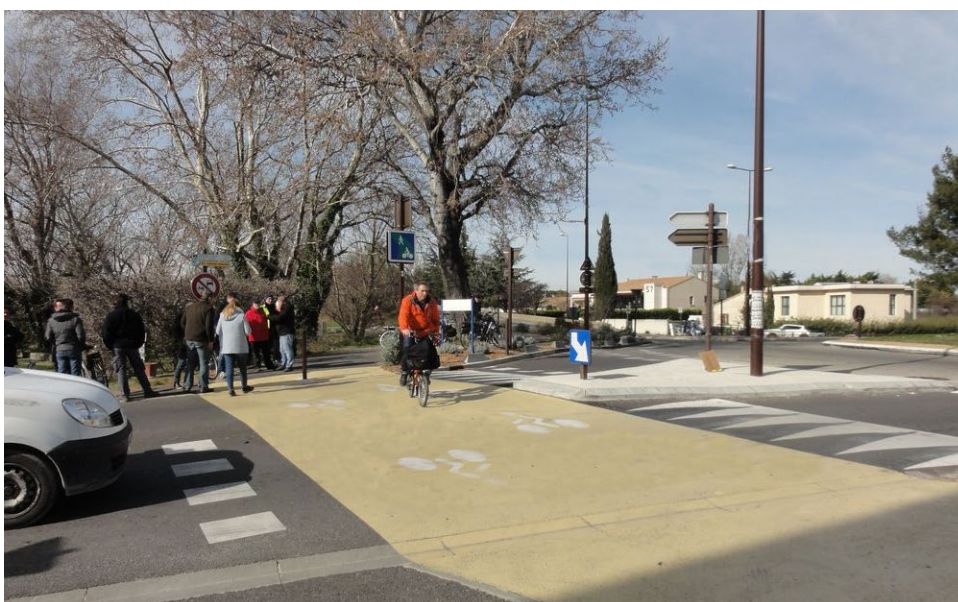
Voie verte rendue prioritaire sur une branche d'un giratoire Source : Cerema
