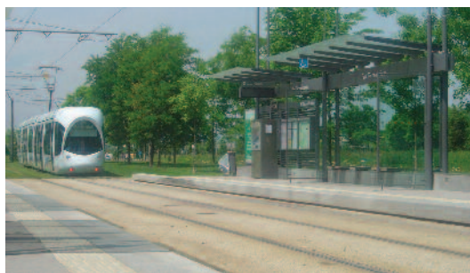
Tramway T2 de Lyon - source CETE Lyon
