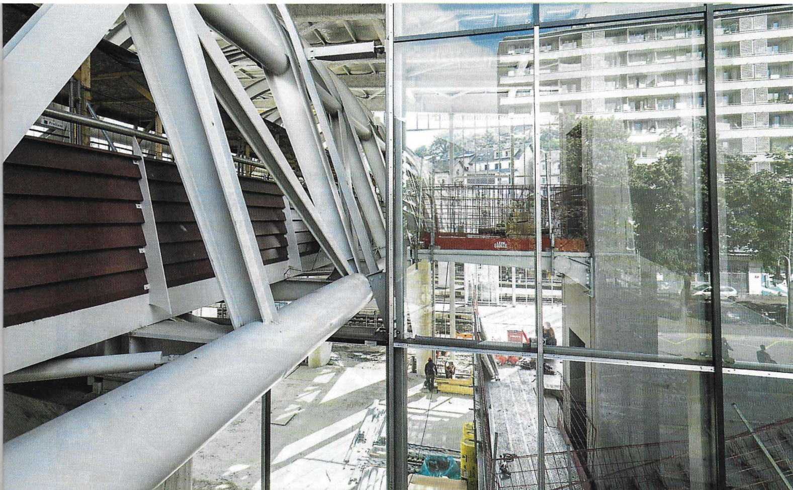
Le très gros chantier du pôle d'échanges multimodaux de la gare du Grand Chambéry doit être achevé pour l'automne 2019.
