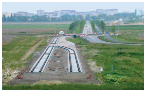
Travaux du tramway de Reims, dans la future ZAC de Bezannes – Source : CETE de l'Est
