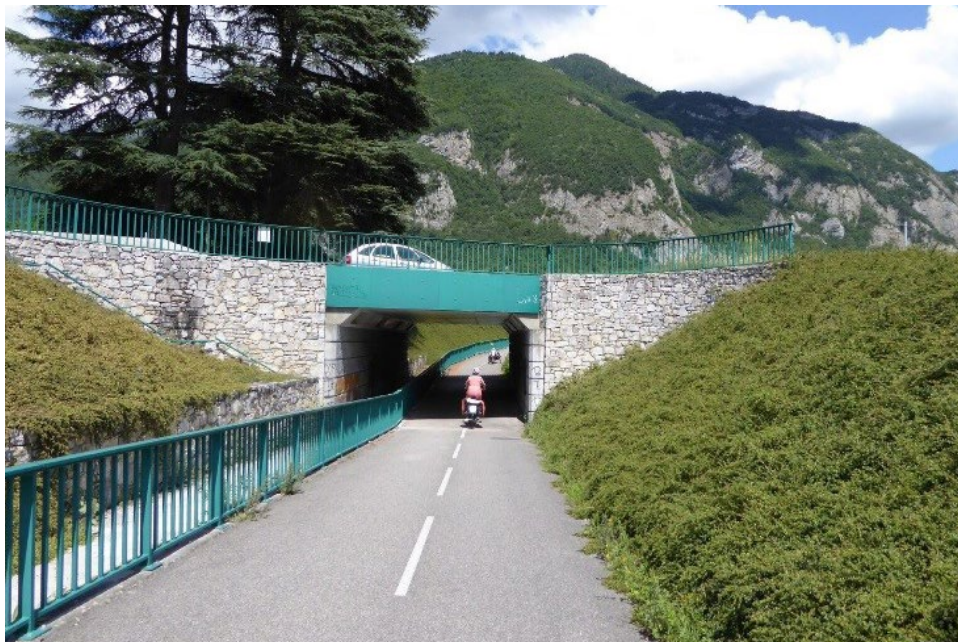
Passage dénivelé Source: Cerema
