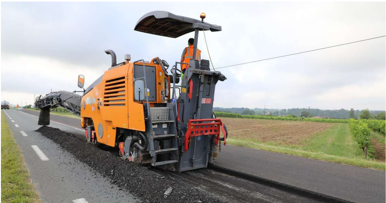
© Photographie Département de la Gironde Travaux écologiques et innovants le 3 juillet sur la RD 670 à Saint Jean de Blaignac
