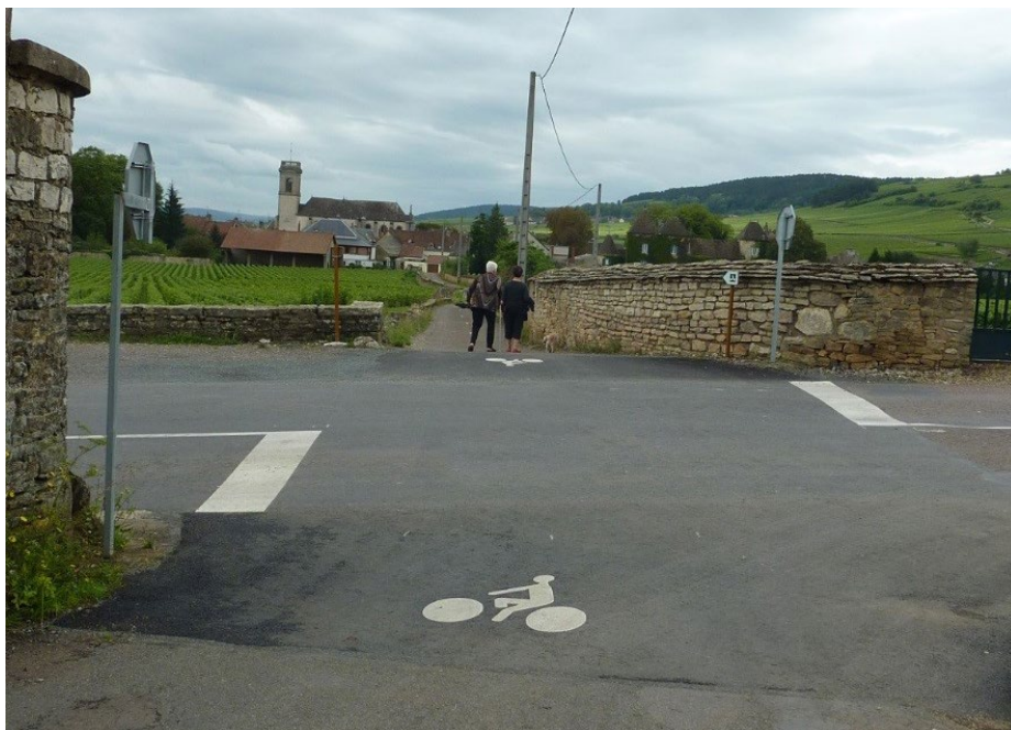
Véloroute prioritaire sur voie secondaire Source : Cerema
