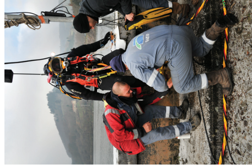
Révision du barrage, 2012.
