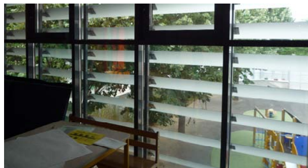
Photo : Pare-soleil dans l'école Lamoricière, école conforme au Plan Climat Energie de Paris, 12 ème arrondissement. © Marie Gantois/Mairie de Paris
