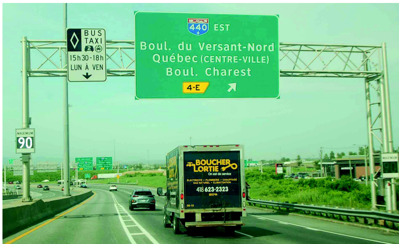
Illustration 2: signalisation verticale statique et panneau dynamique de régulation des vitesses
