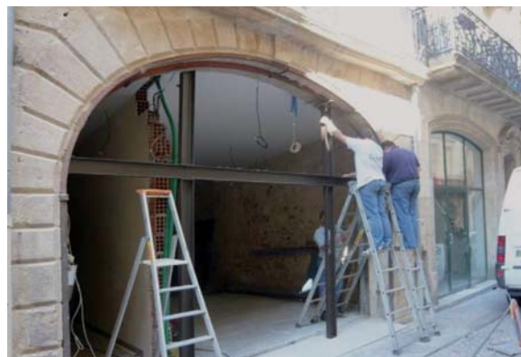
Réhabilitation de la façade
