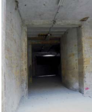
Local avant les travaux
