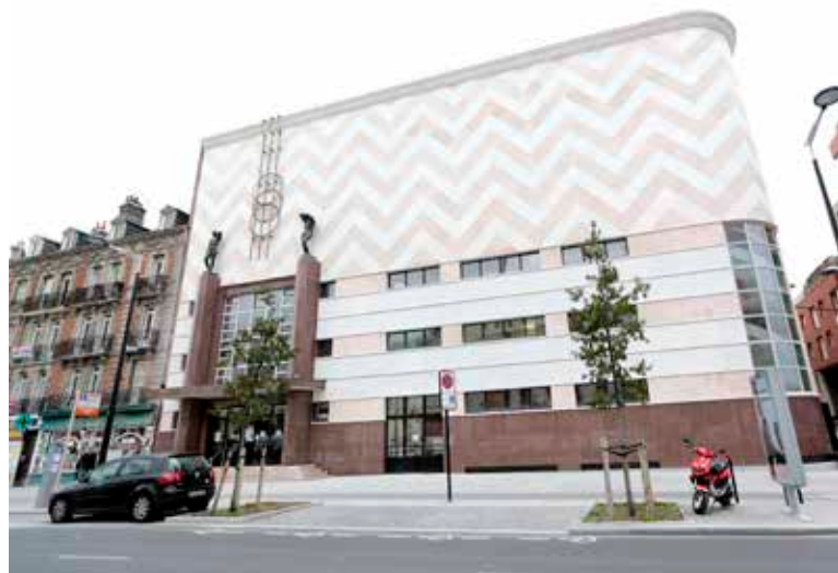
Ville du Havre - Réfection d'une piscine municipale, opération soutenue par la Fondation du Patrimoine et la Fondation Total
