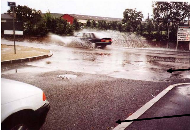
Chaussée à structure réservoir, Craponne (CERTU - 1994)
