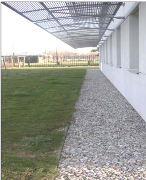
▶ Tranchées sous toit
