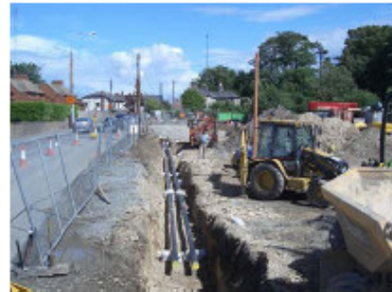
Pose d'un double circuit le long d'une route nationale en Italie: réduction des nuisances et utilisation des synergies entre ouvrages (2007)
