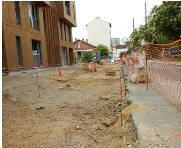
Nouvelles étanches en chantier dans l'EcoQuartier Hoche à Nanterre
