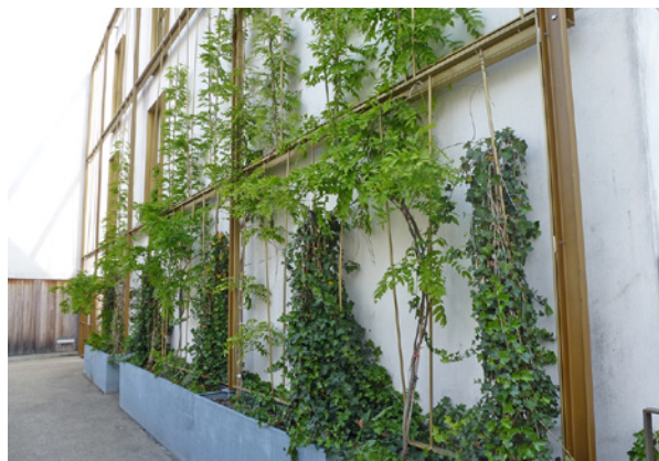
Murs végétalisés dans un bâtiment des Docks de Ris-Orangis à Ris-Orangis
