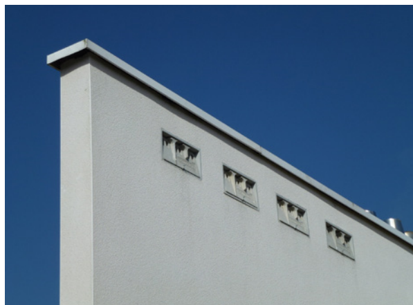
Nichoirs intégrés dans un bâtiment dans le quartier de la Barberie à Changé
