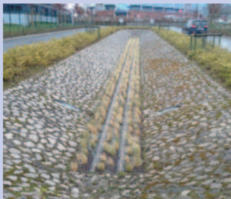
Noue réalisée avec caissons et 3 caniveaux parallèles Drainclean de Funke sans grille.
