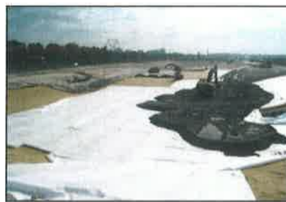
Figure 5. Étanchéité et lestage (octobre 2009)
