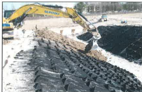
Figure 6. Géoconteneur et terre végétale sur les berges de la rivière artificielle (mars 2010)
